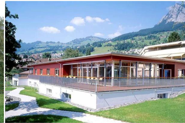
Anbau Demenzabteilung Haus Franziskus 2007
